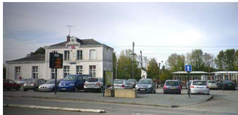
La ligne Illenoo Rennes-Pipriac dessert Lohéac et son aire de connexion intermodale (croisement RD177 et RD772)
